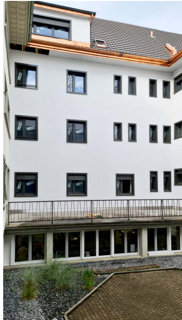
Die fertiggestellte Fassade im Sommer 21
